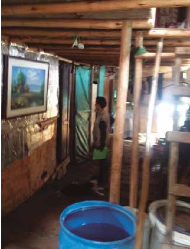
^ Interior de una vivienda construida en madera y plástico en Altos de la Florida (Pablo Cortés Ferrández)
