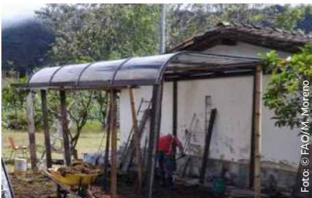
Foto 13. Centro de acopio en construcción en el emprendimiento de hortalizas en Asofruacar.
