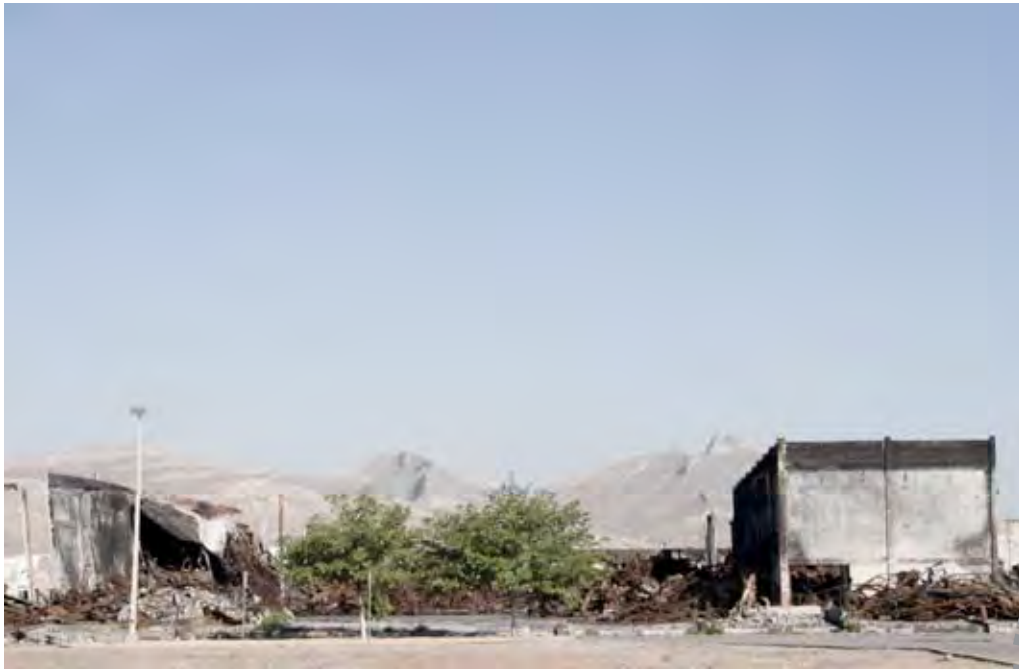
Maquiladora incendiada en desuso desde 2009 | Burnt assembly-machine obsolete since 2009
