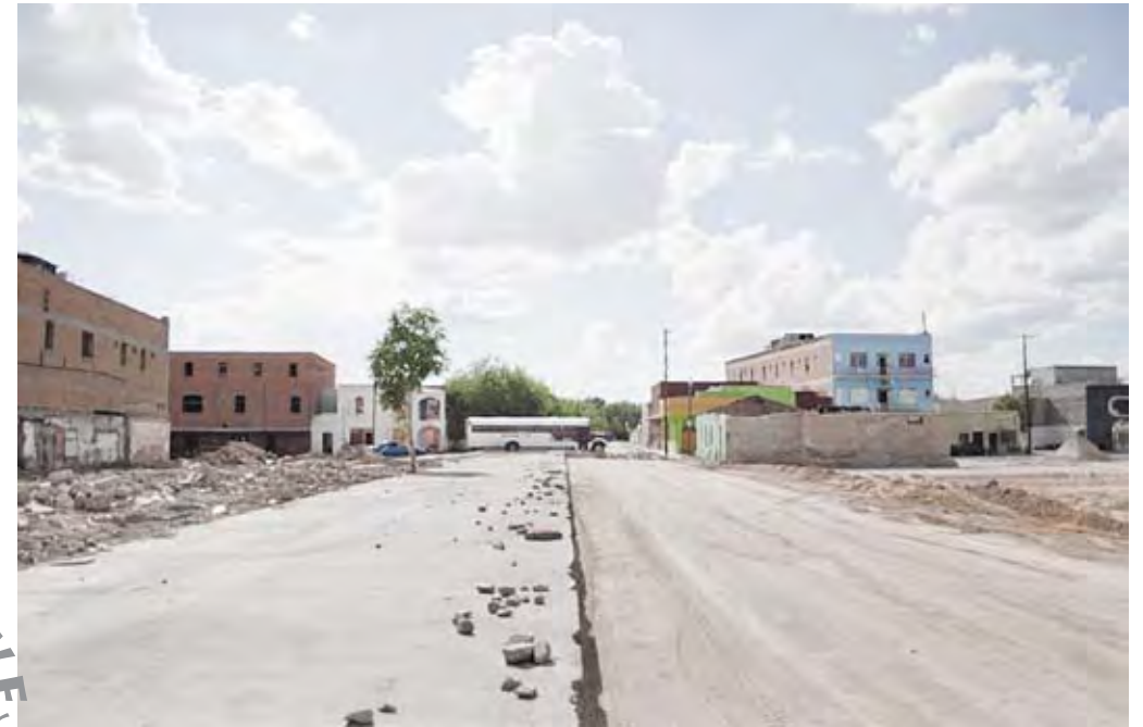
Obras de demolición del centro histórico desde 2007 | Demolition of the downtown since 2007
