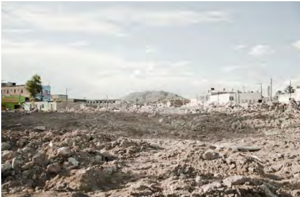
Obras de demolición del centro histórico desde 2007 | Demolition of the downtown since 2007
